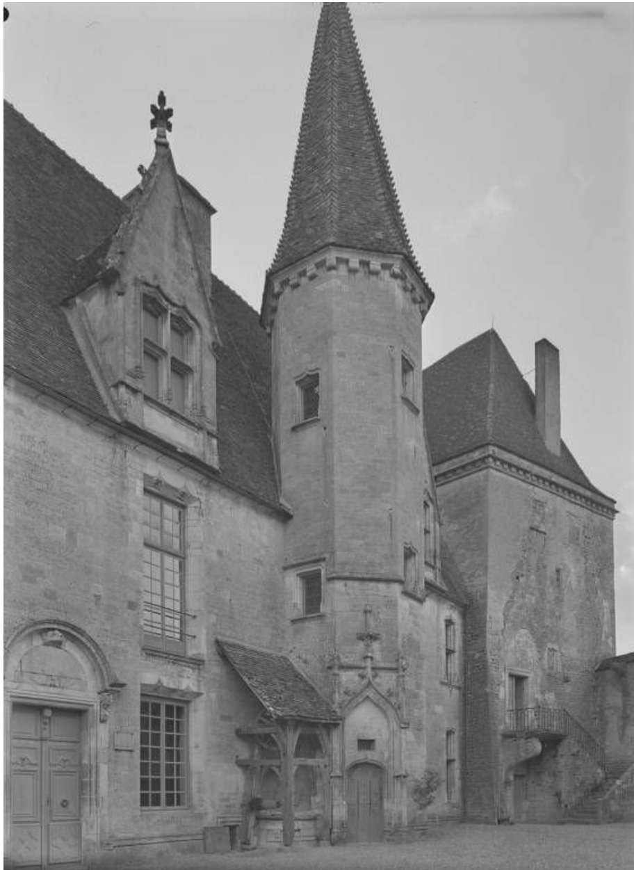
Corps de logis, vue partielle (photo prise en 1969).
