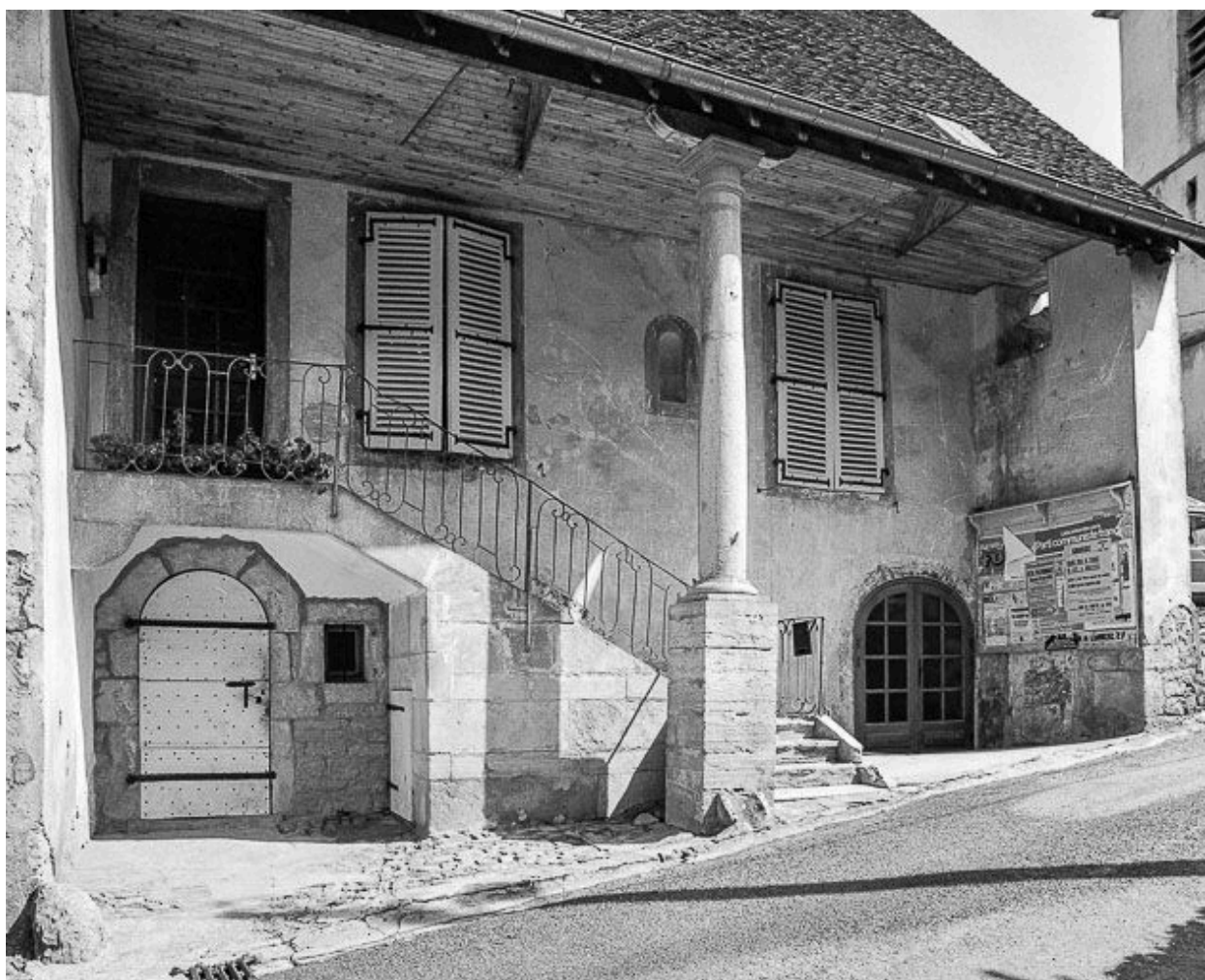
Façade antérieure, partie droite.
