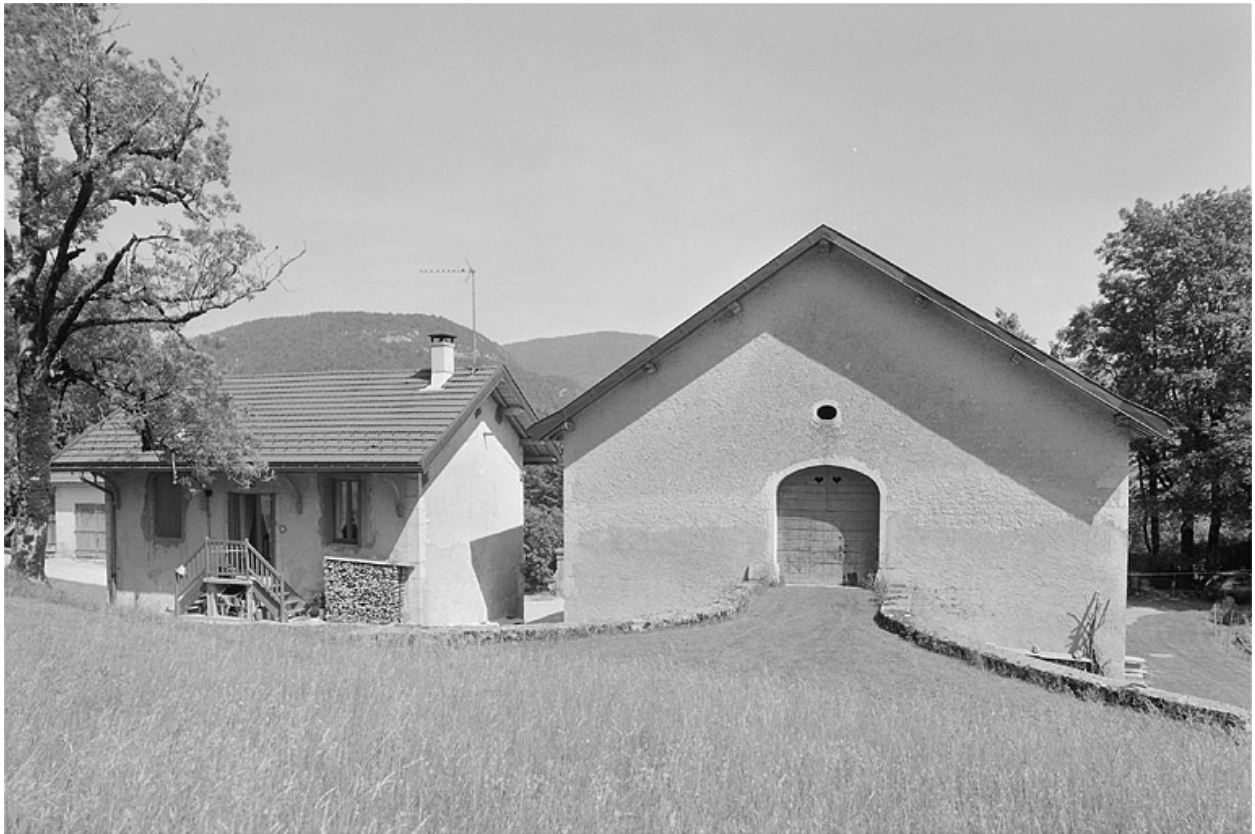
Façade postérieure de la ferme et de la remise à automobile.
