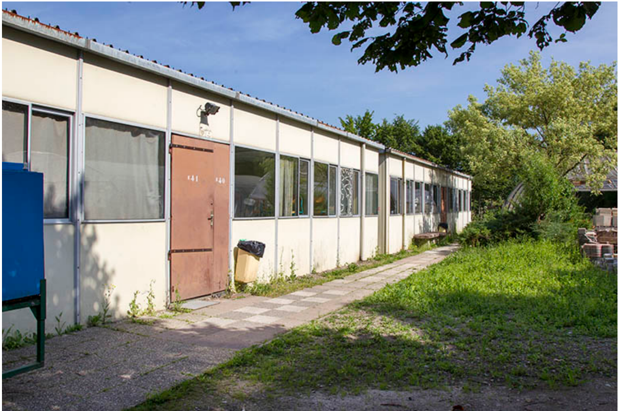
Façade postérieure des salles de cours nord-est.
