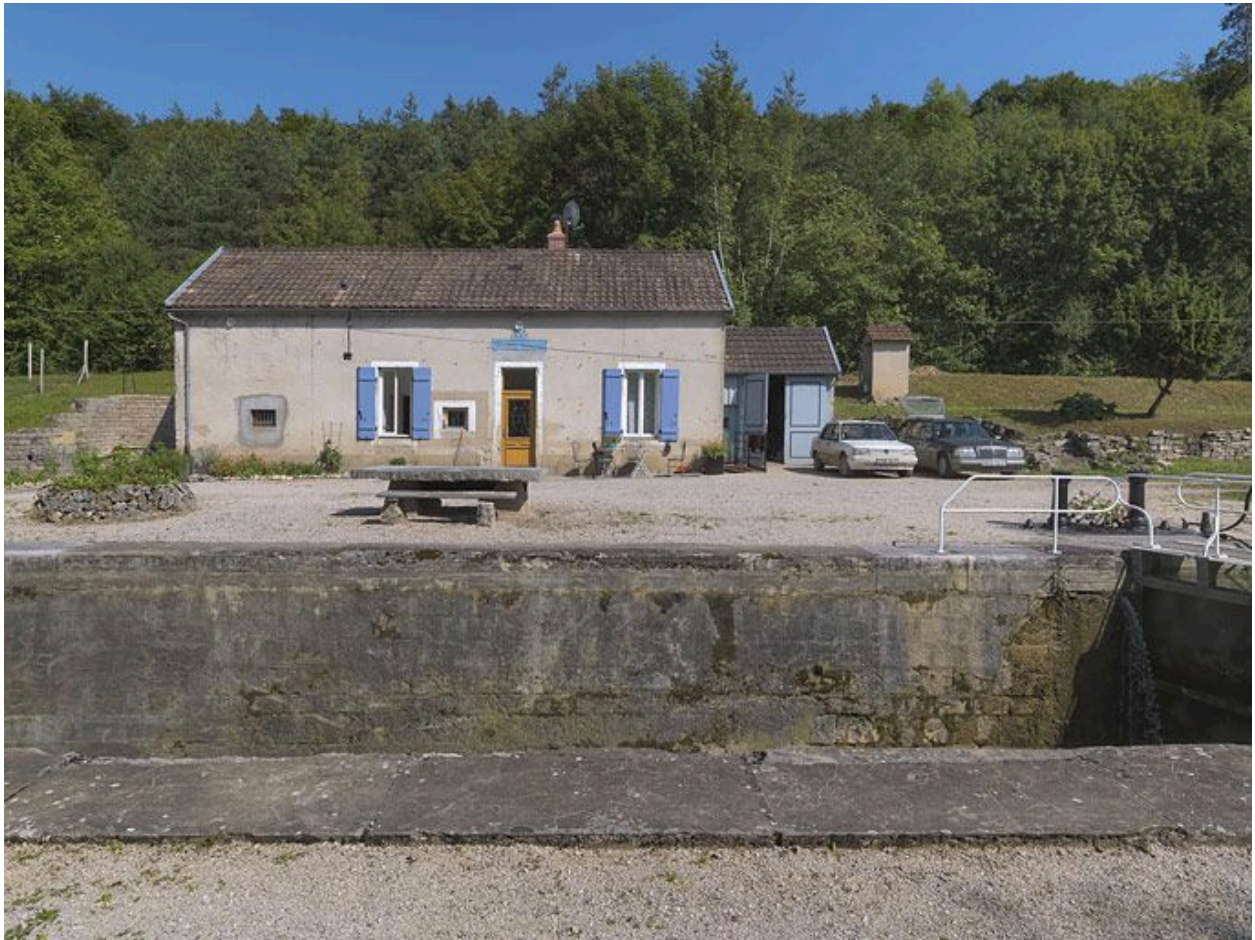
Maison éclusière de face.
