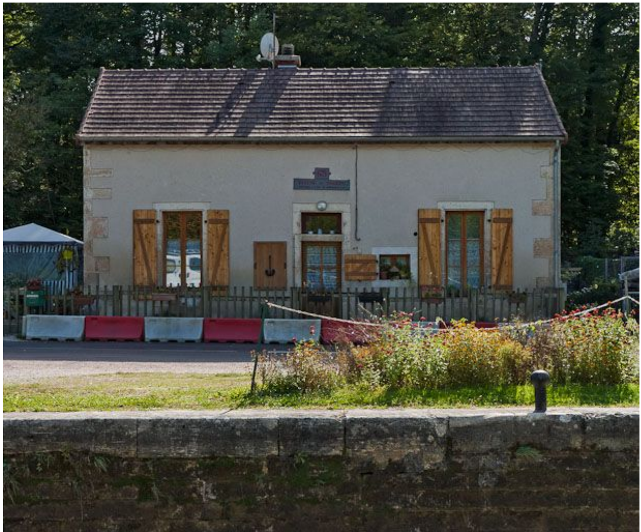
Vue de face de la maison éclusière.
