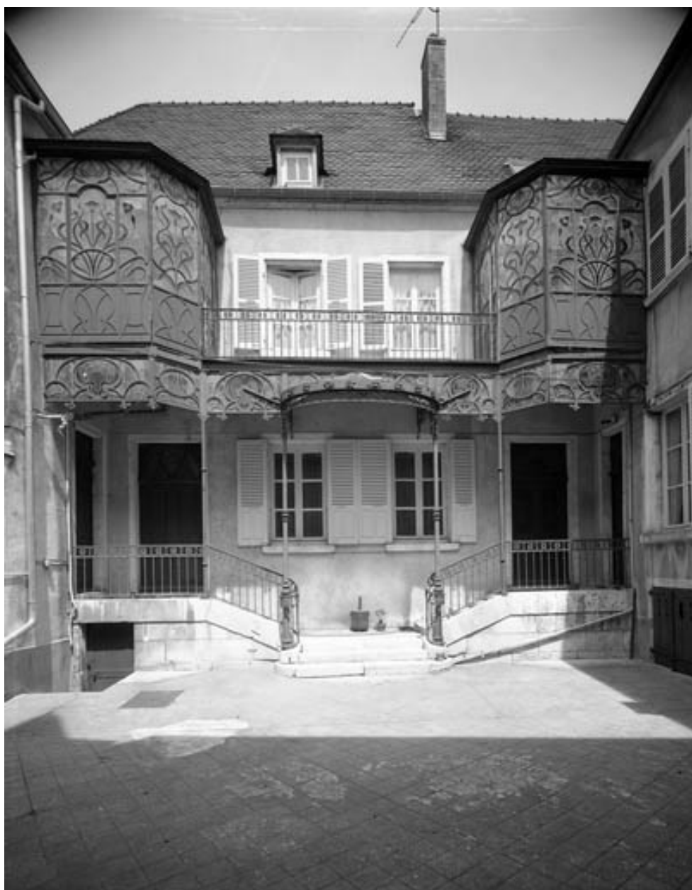
Façade antérieure sur cour, de face.
