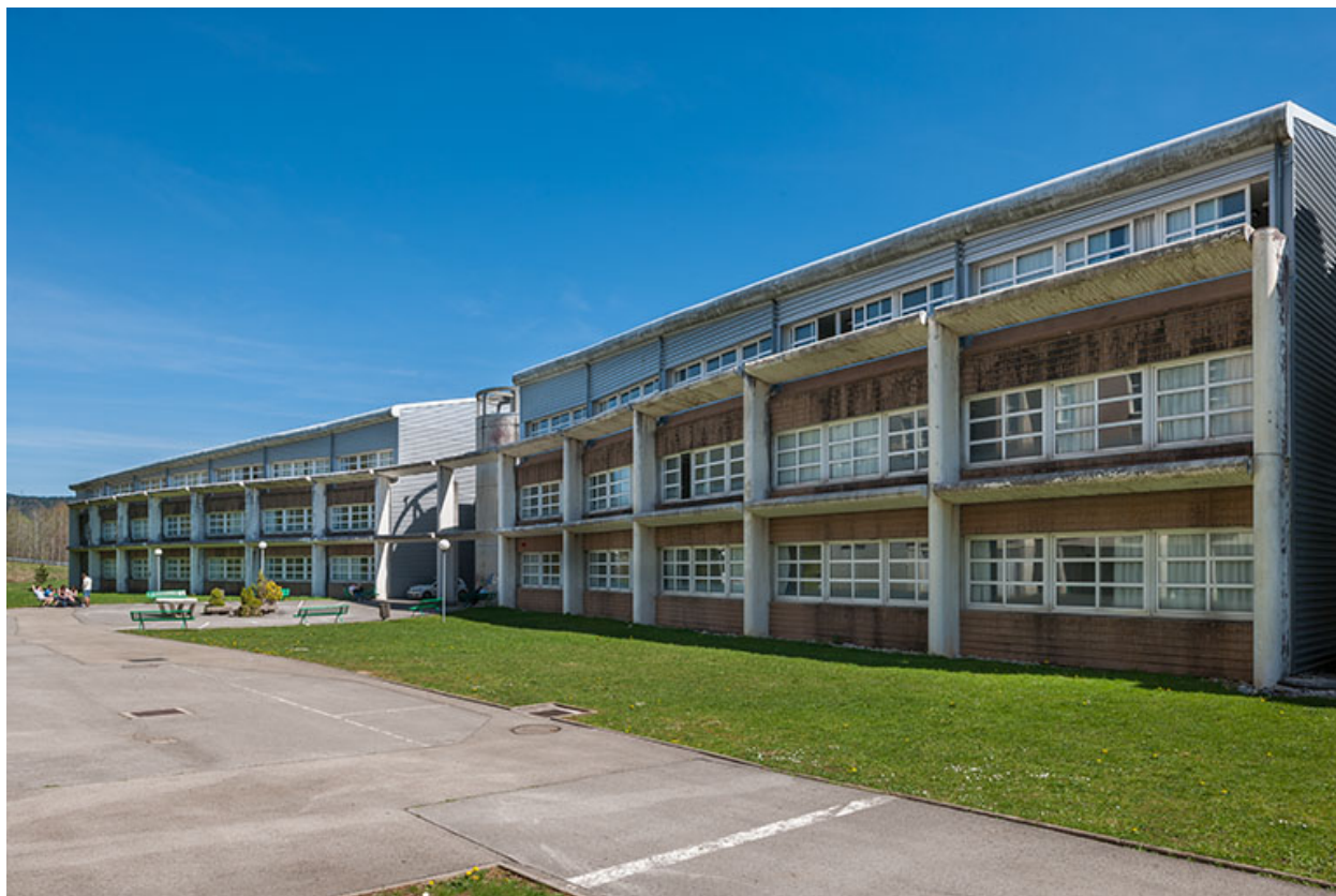
Externat : façades sur rue intérieure, partie Nord.
