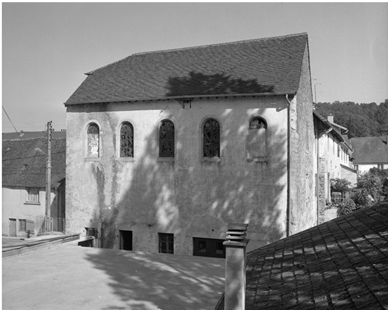
Chapelle : façade latérale droite.
