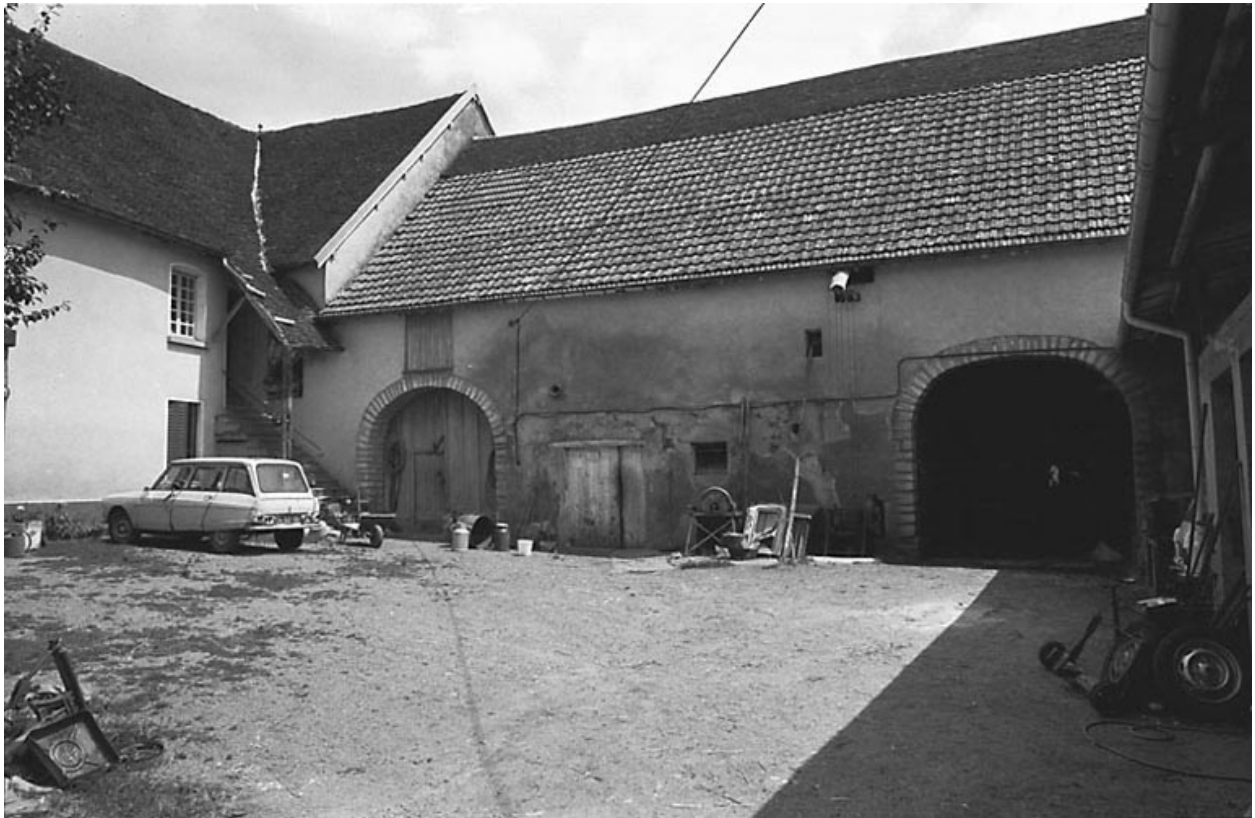
Vue des bâtiments agricoles dans la cour.
