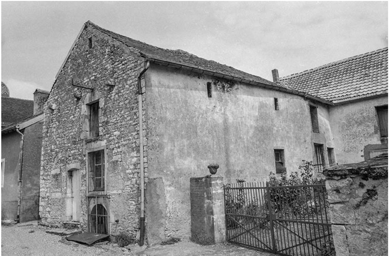
Maison située 7 rue Sainte-Catherine : façades antérieure et latérale droite.
