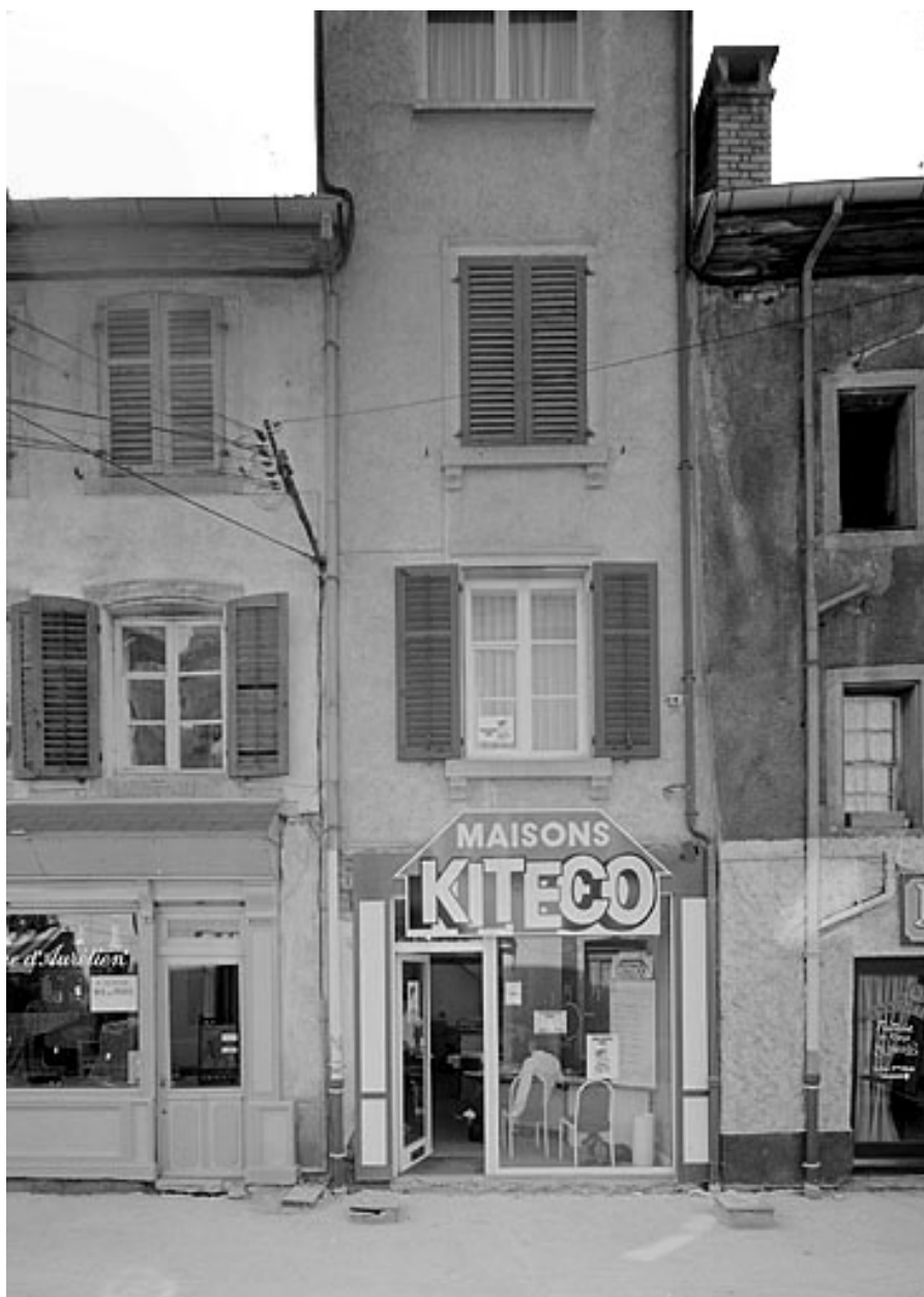
Elévation sur la rue de Belfort du corps de bâtiment occupant l'emplacement de l'ancienne grange.
