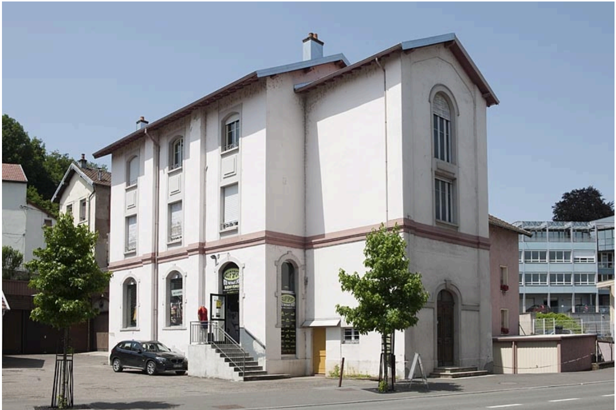
Bâtiments administratifs (?). Vue depuis le sud-ouest.
