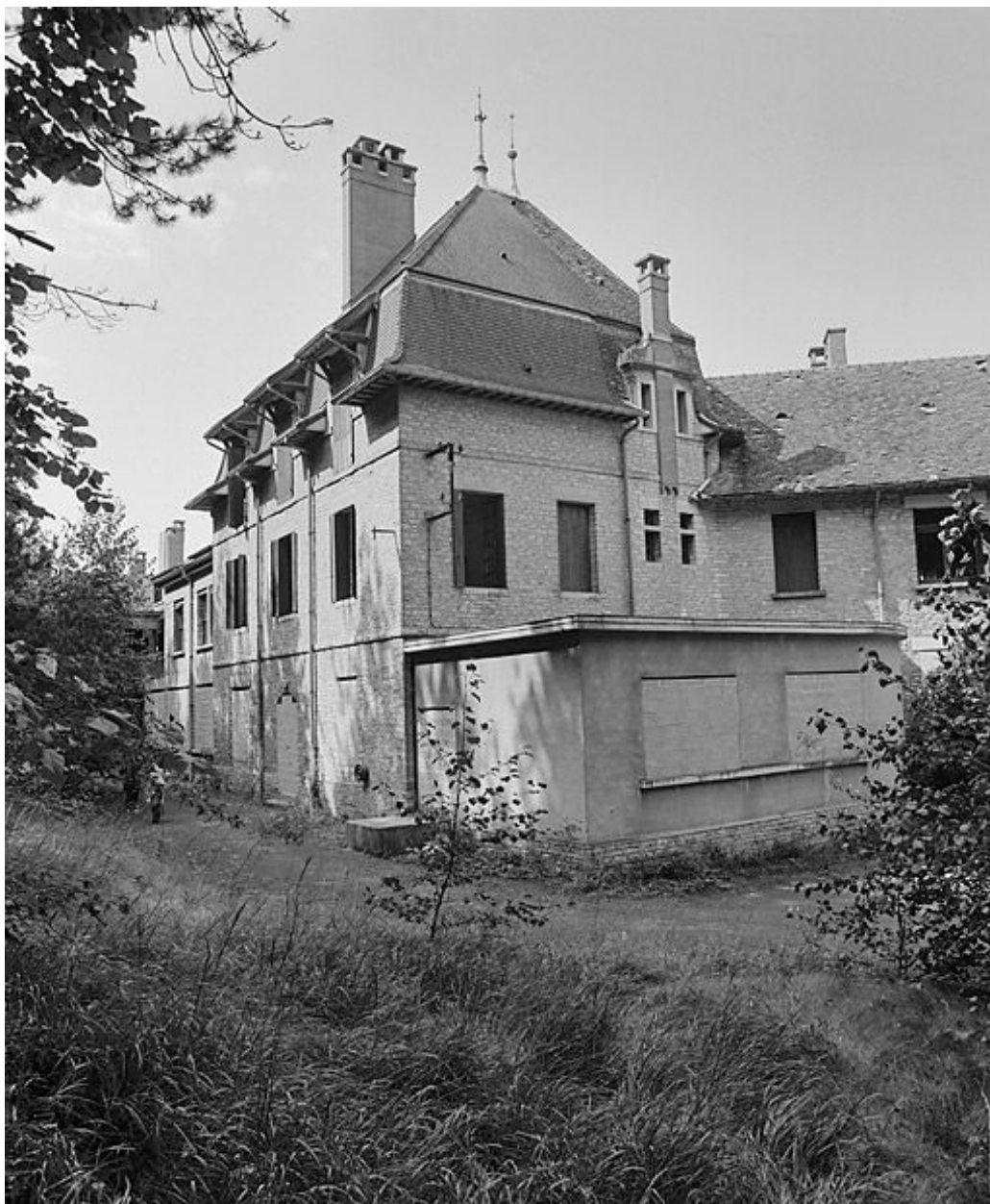
Pavillon du corps de bâtiment central.
