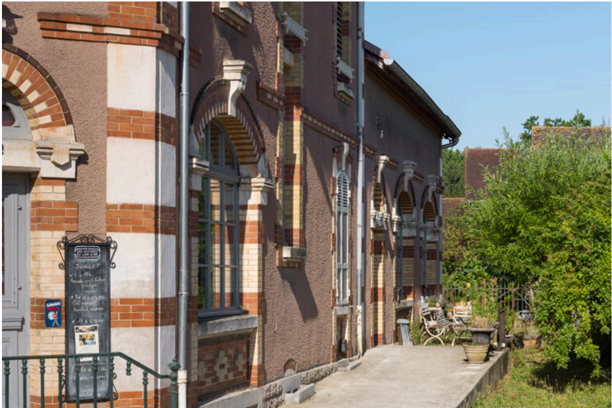
Hôtel-restaurant et salle de bal : façade antérieure, au rez-de-chaussée.
