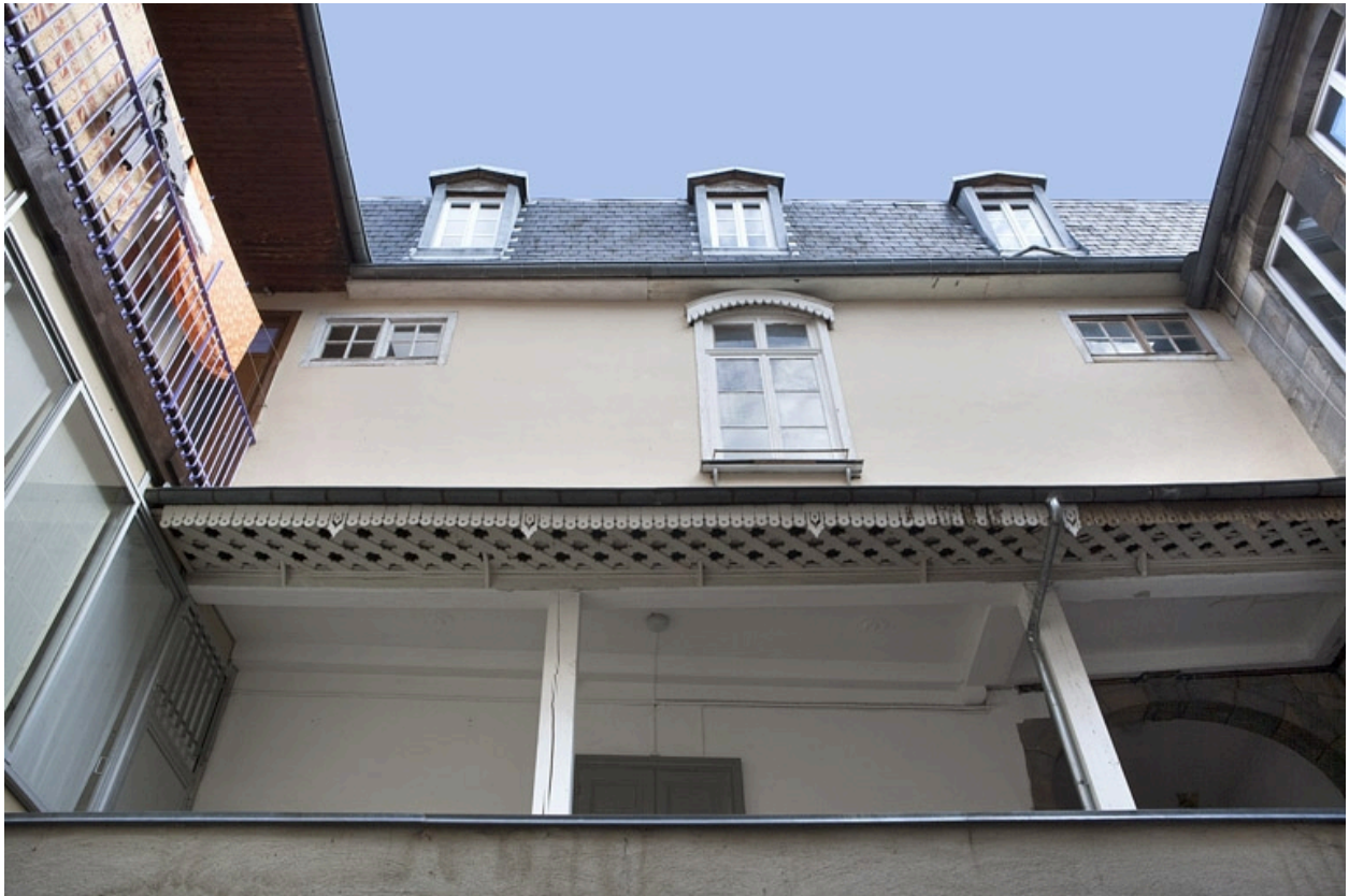
Détail de la coursière depuis la cour : de face.
