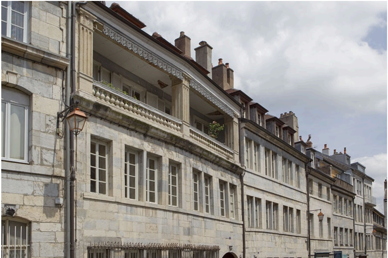
Façade sur rue du logis principal : détail de l'étage de surélévation, de trois quarts gauche.
