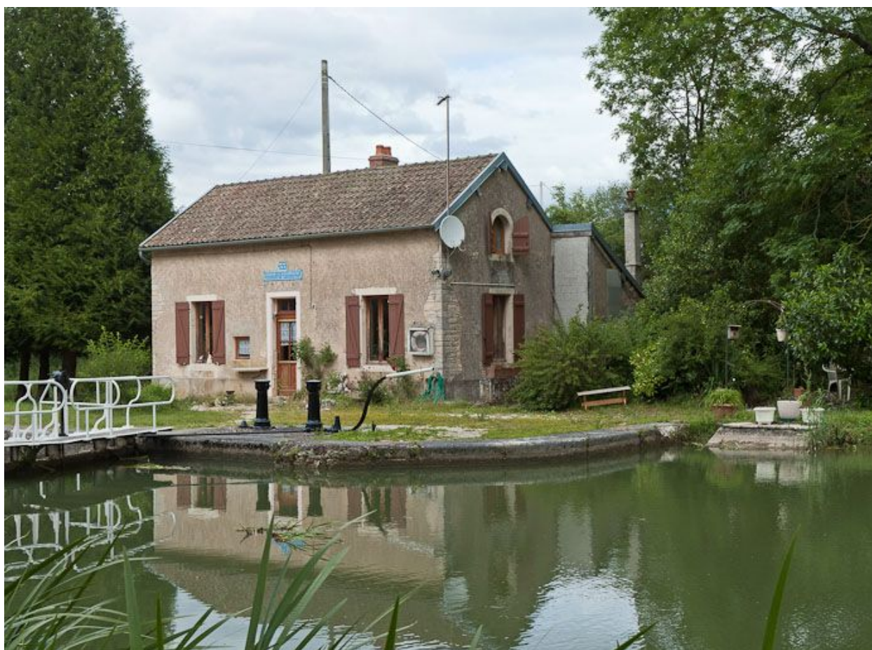
Vue d'ensemble du site d'écluse.
