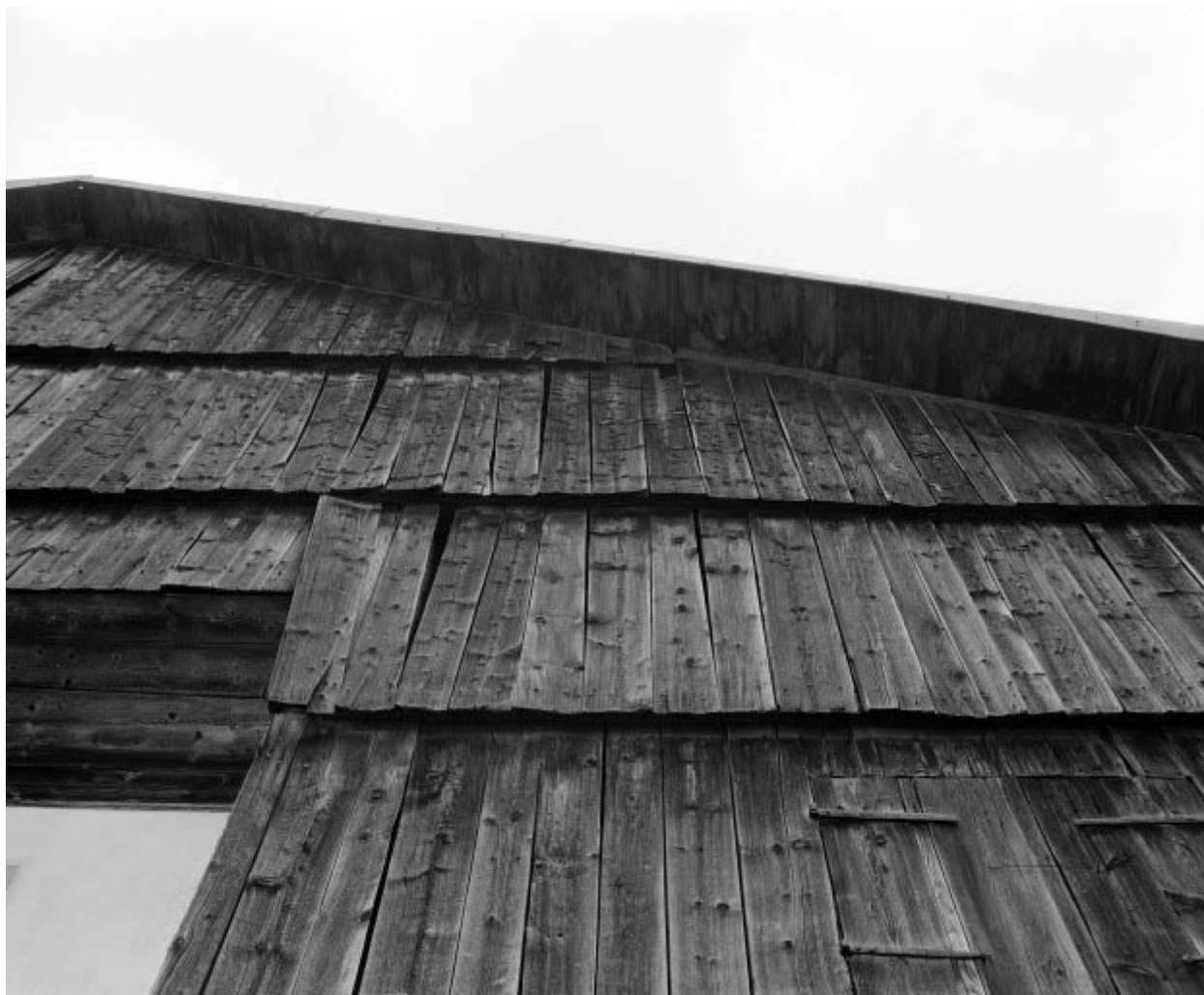
Détail de la lambrechure antérieure : rang de planches.
