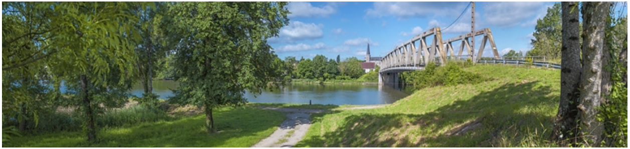
Vue d'ensemble, rive gauche.
