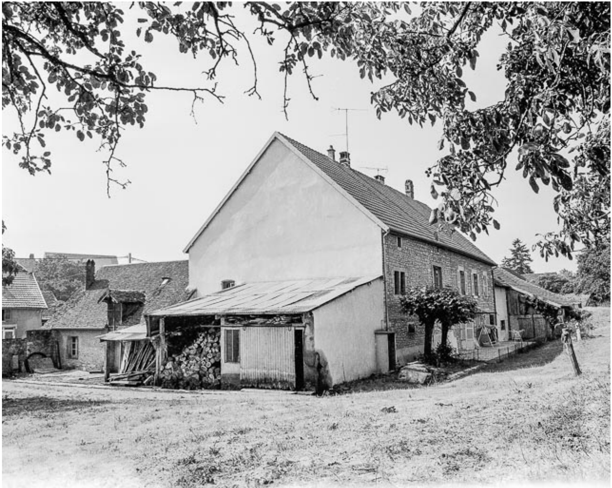
Maison cadastrée 1973 AB 11 située rue d'Aval à Chenevrey : façades postérieure et latérale droite.
