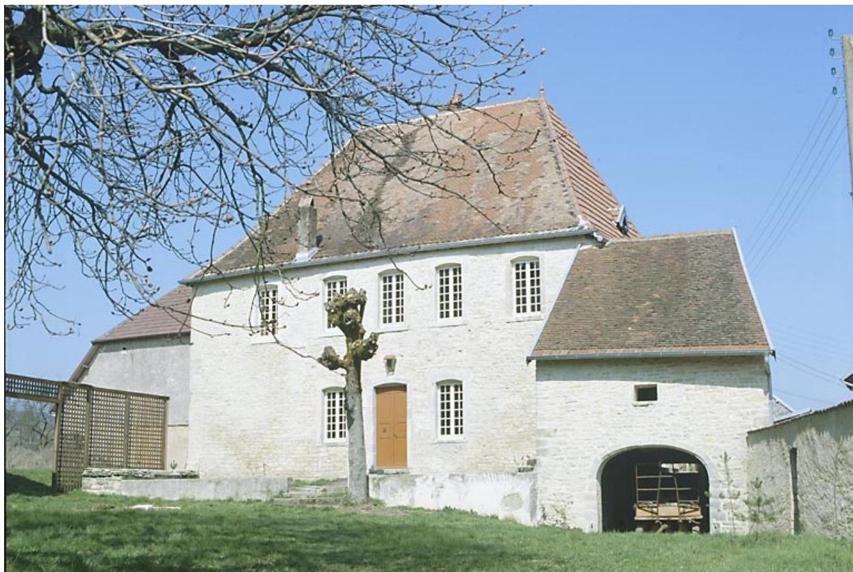
Vue d'ensemble éloignée de la maison d'habitation.
