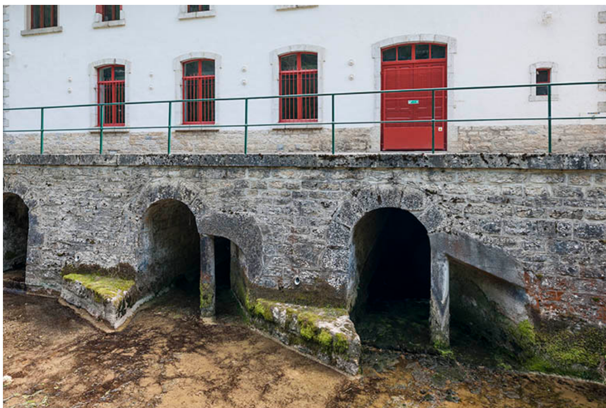
Conduits d'évacuation des groupes turbo-alternateurs.
