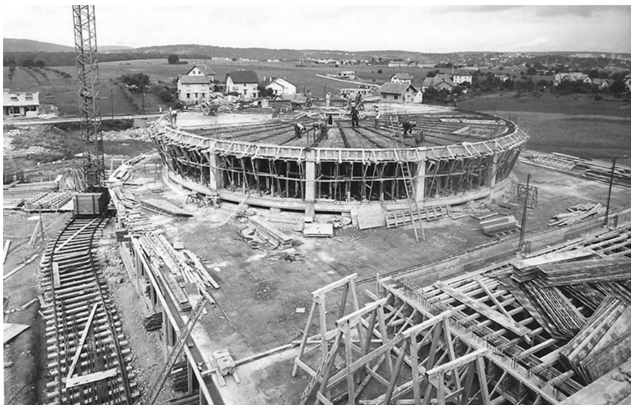
Vue du chantier de construction.
