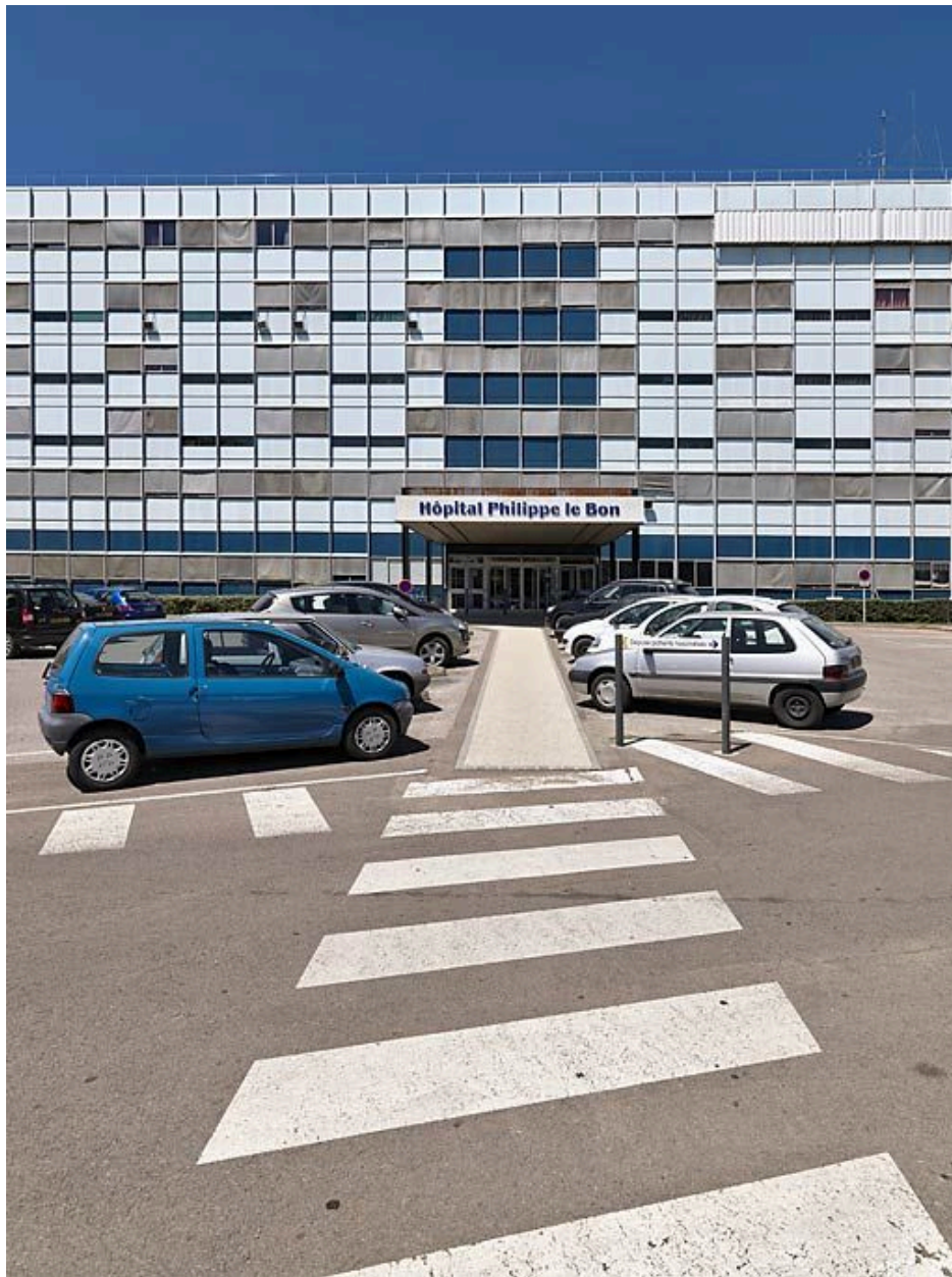
Bâtiment principal, partie centrale de la façade.
