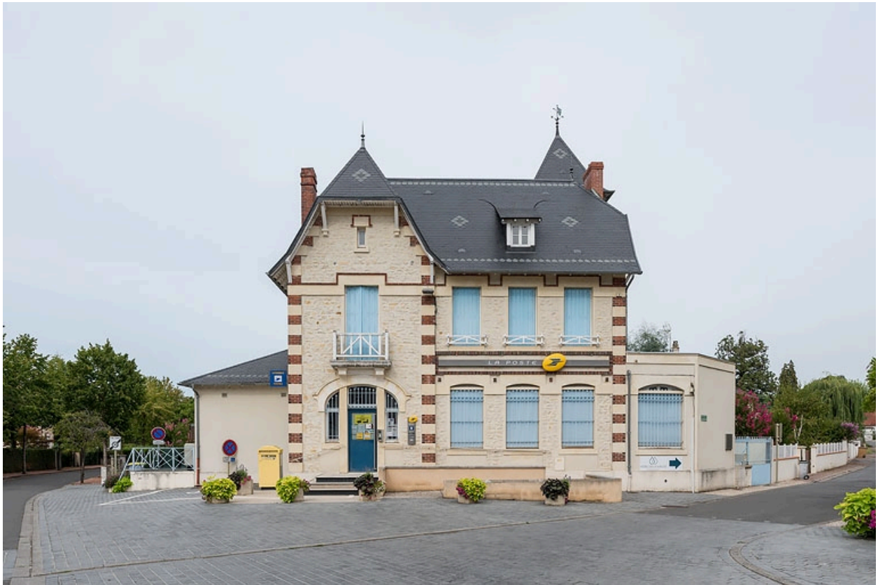
Façade, vue de face.
