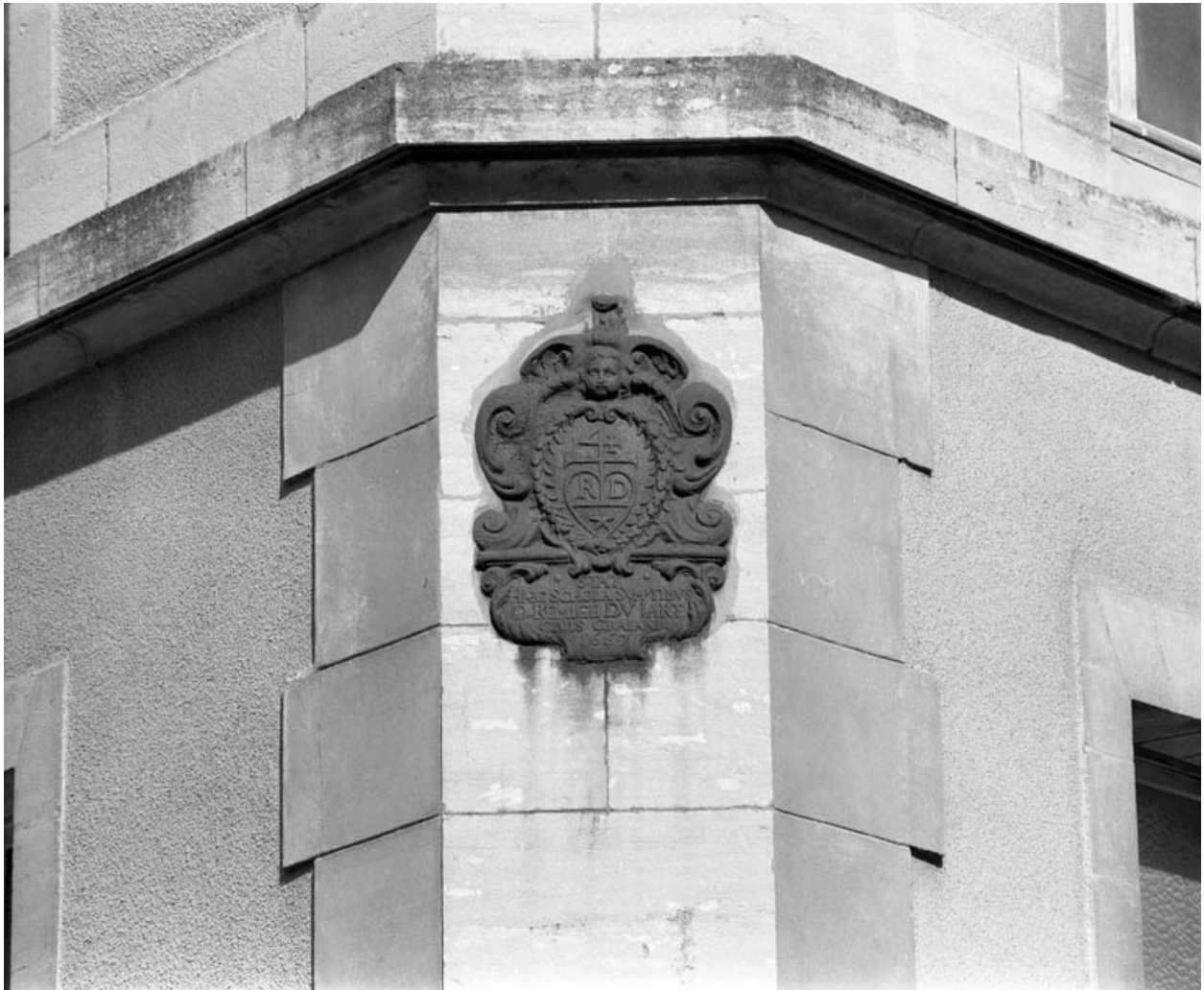
Plaque de fondation d'une classe, sur aile droite du bâtiment sur cour, datée 1667 : vue d'ensemble en 1991.
