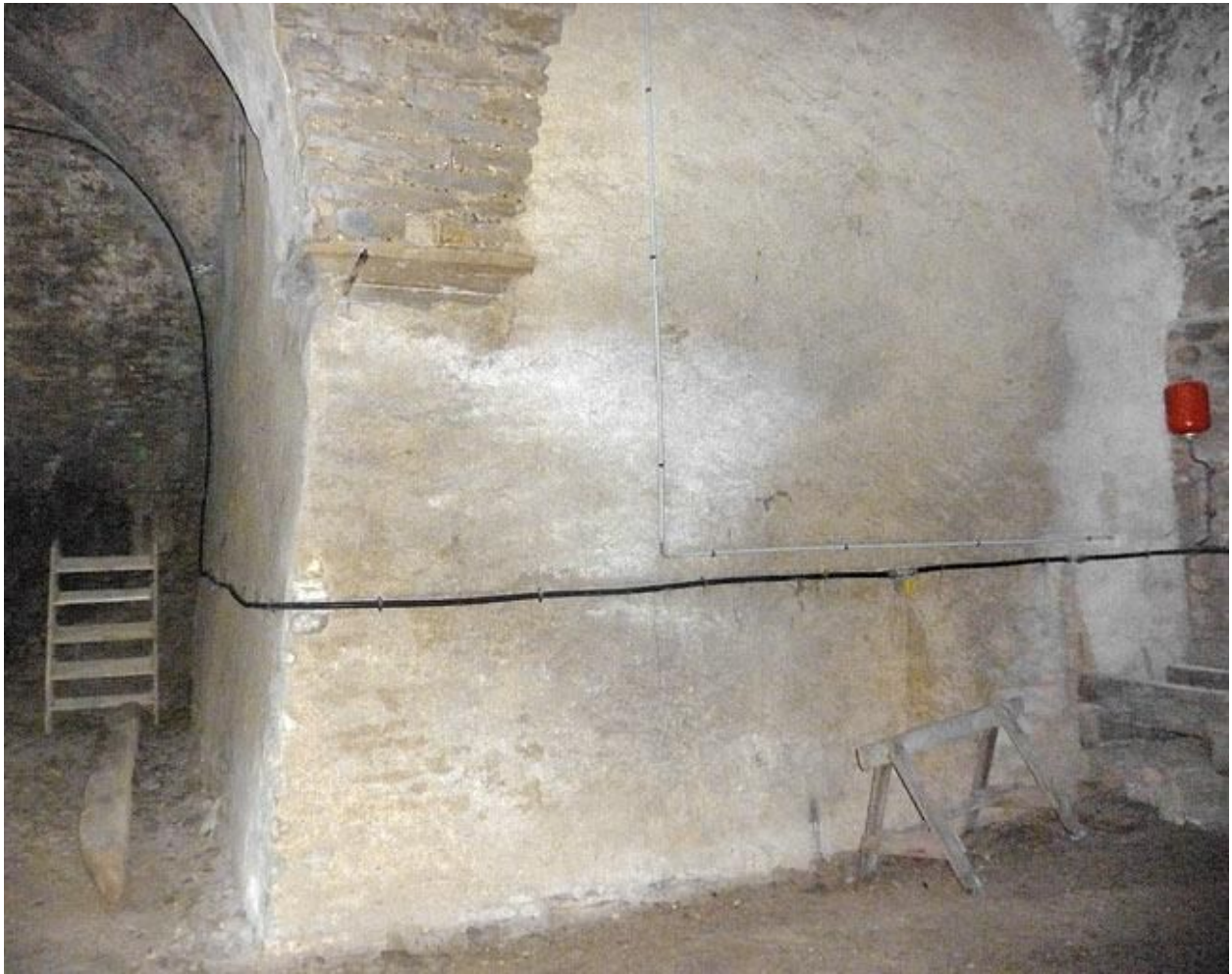
Cave sous la grange, travée murée.
