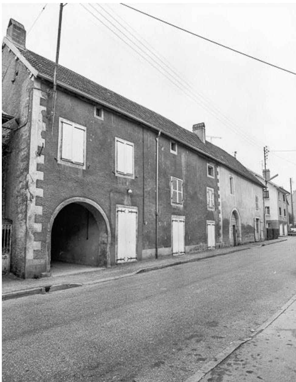
Oiselay-et-Grachaux (Oiselay) : bâtiments sur rue avec habitation sur porche vus de trois quarts gauche.
