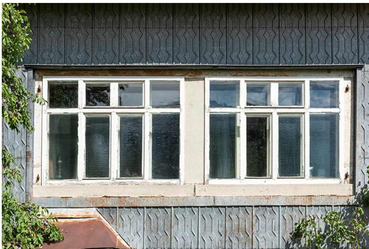
Façade latérale gauche : fenêtres de l'atelier.
