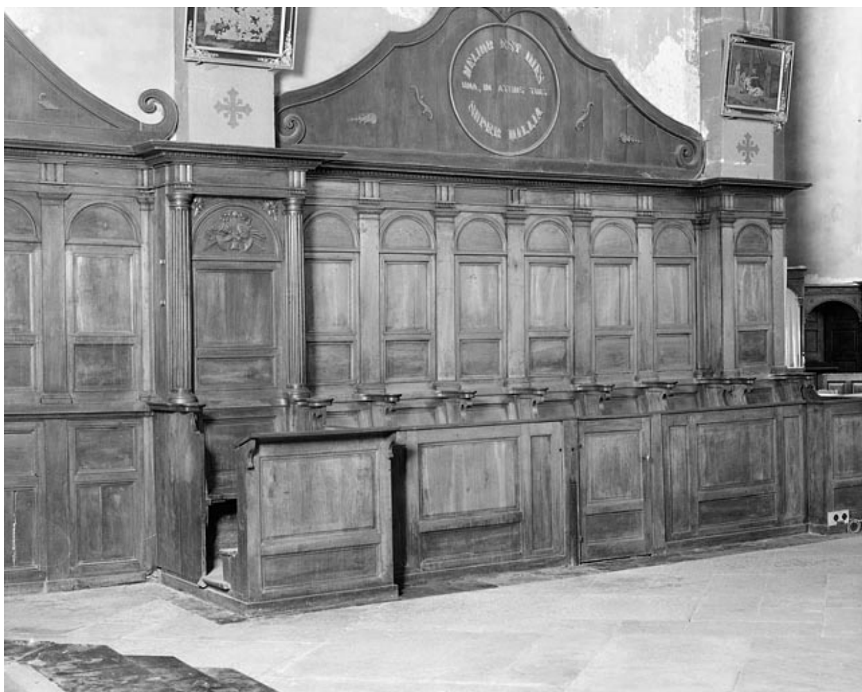
Lambris et stalles du mur sud du chœur.
