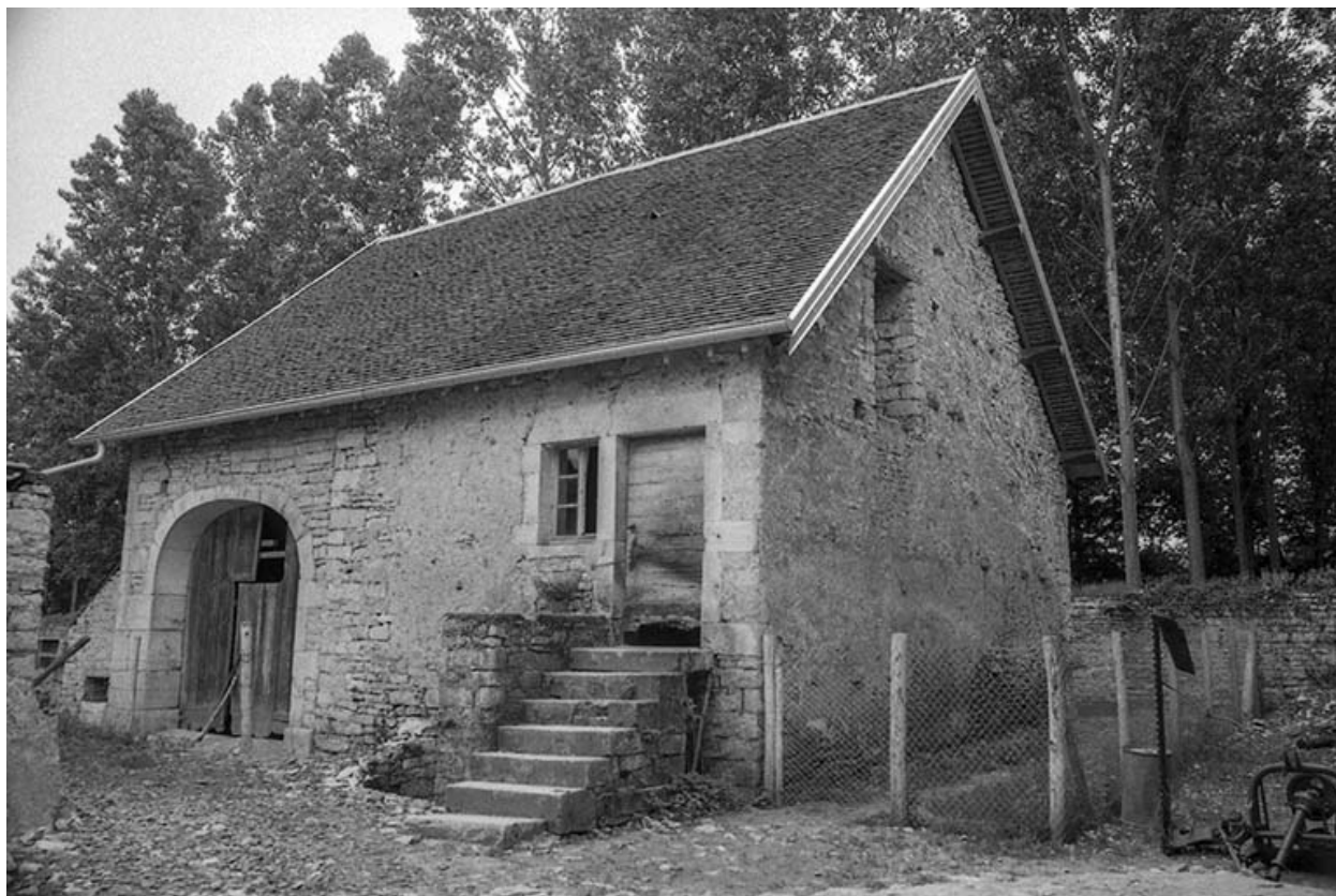
Malans, maison située rue des Châteaux : exemple de ferme-bloc à deux travées.
