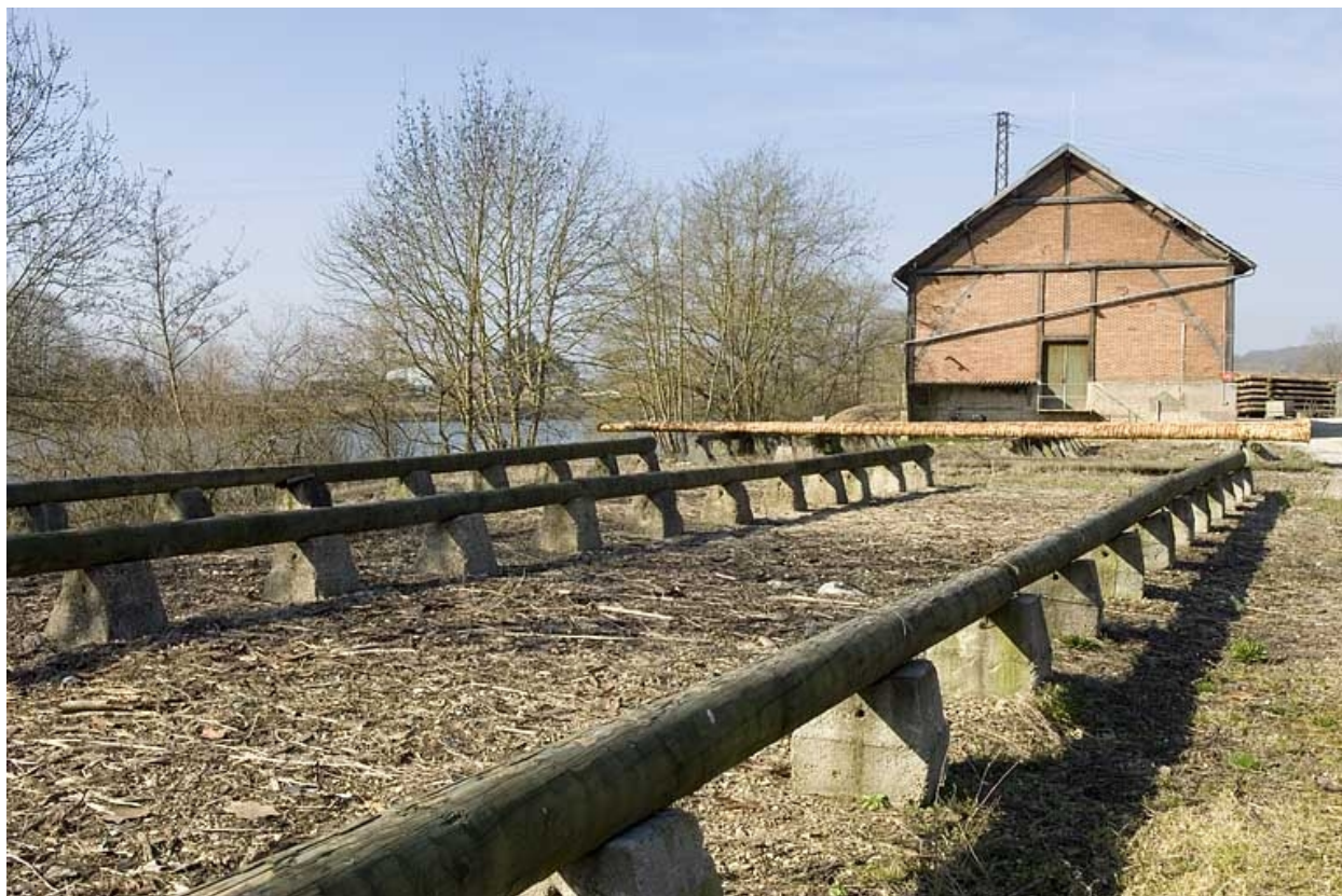
Aire de stockage et magasin industriel.
