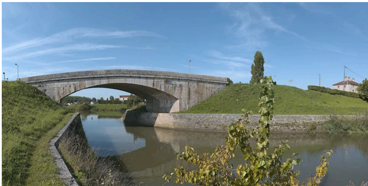
Vue d'ensemble prise d'aval.
