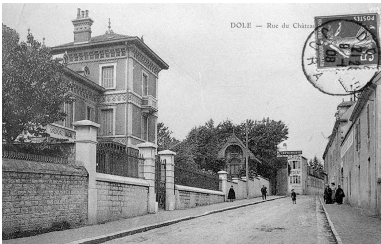
Dole - Rue du Château d'eau.
