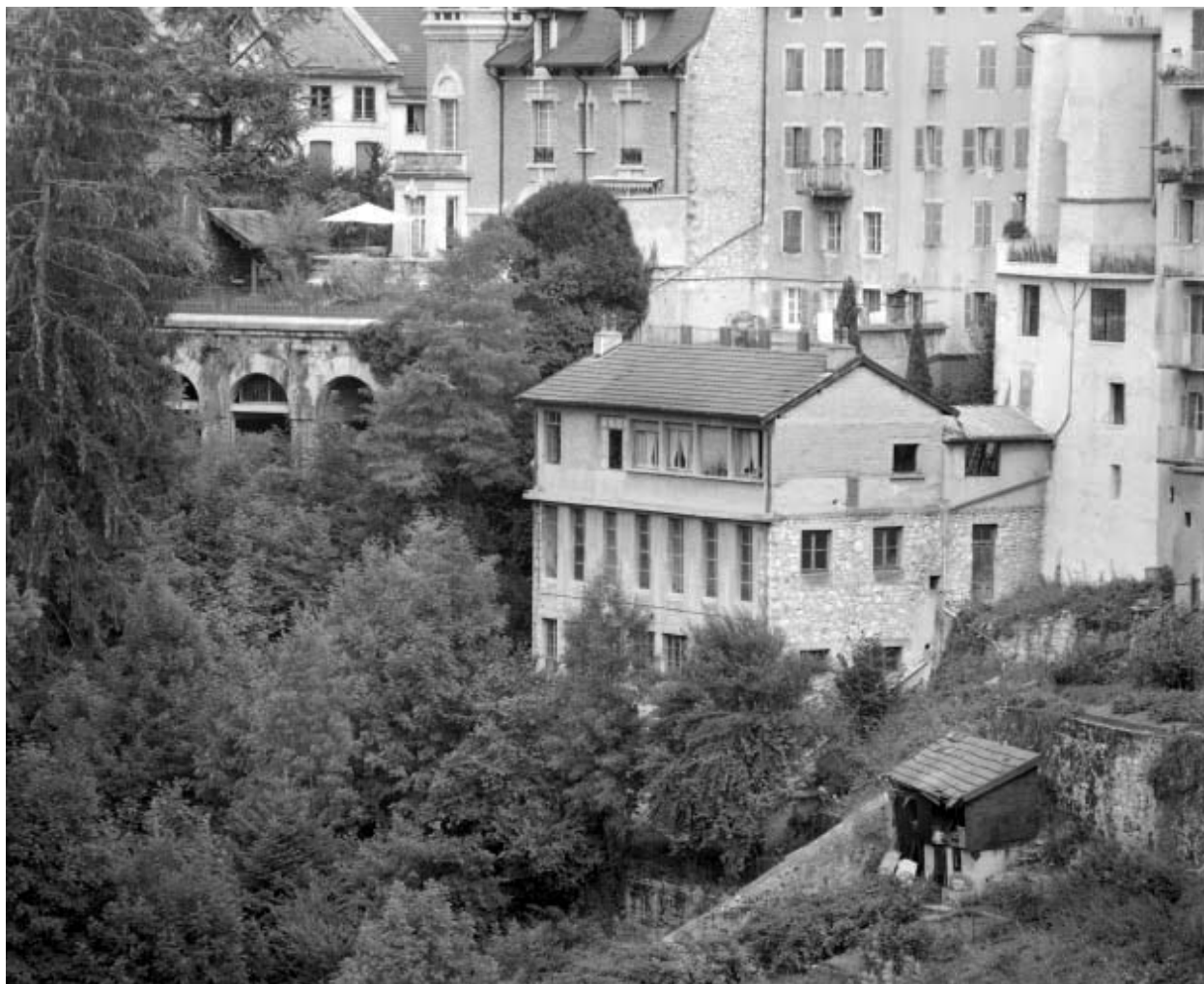
Deuxième usine depuis le sud.
