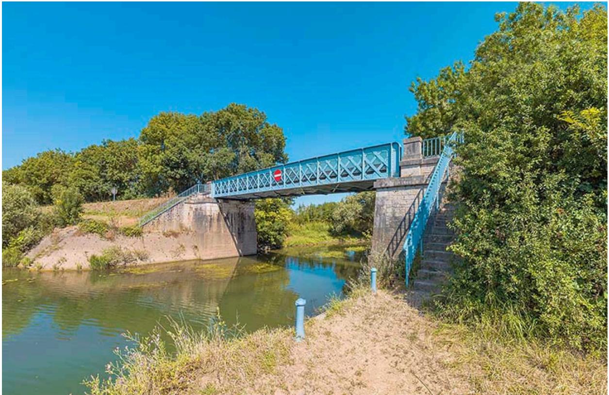
Le pont sur la Dheune, vu d'amont.
