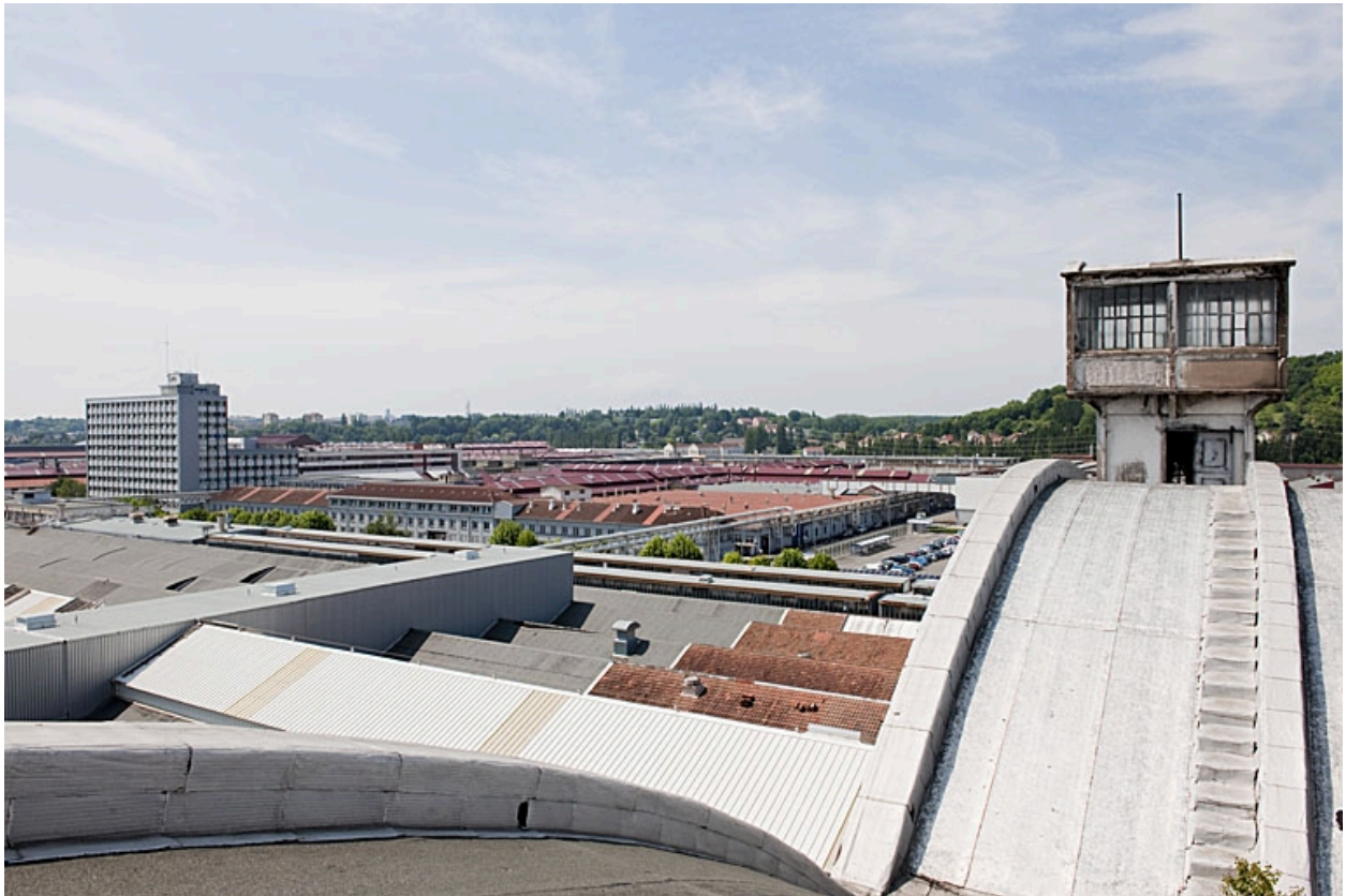
Vue d'ensemble de la partie nord-ouest du site.
