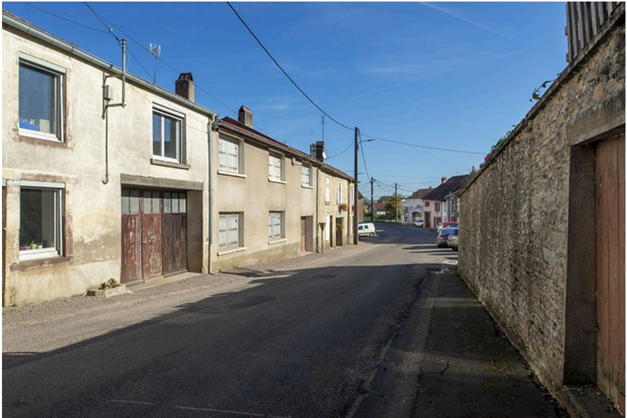
Trois quarts gauche des façades des maisons, 1, 3 et suivants, vers le nord-est.
