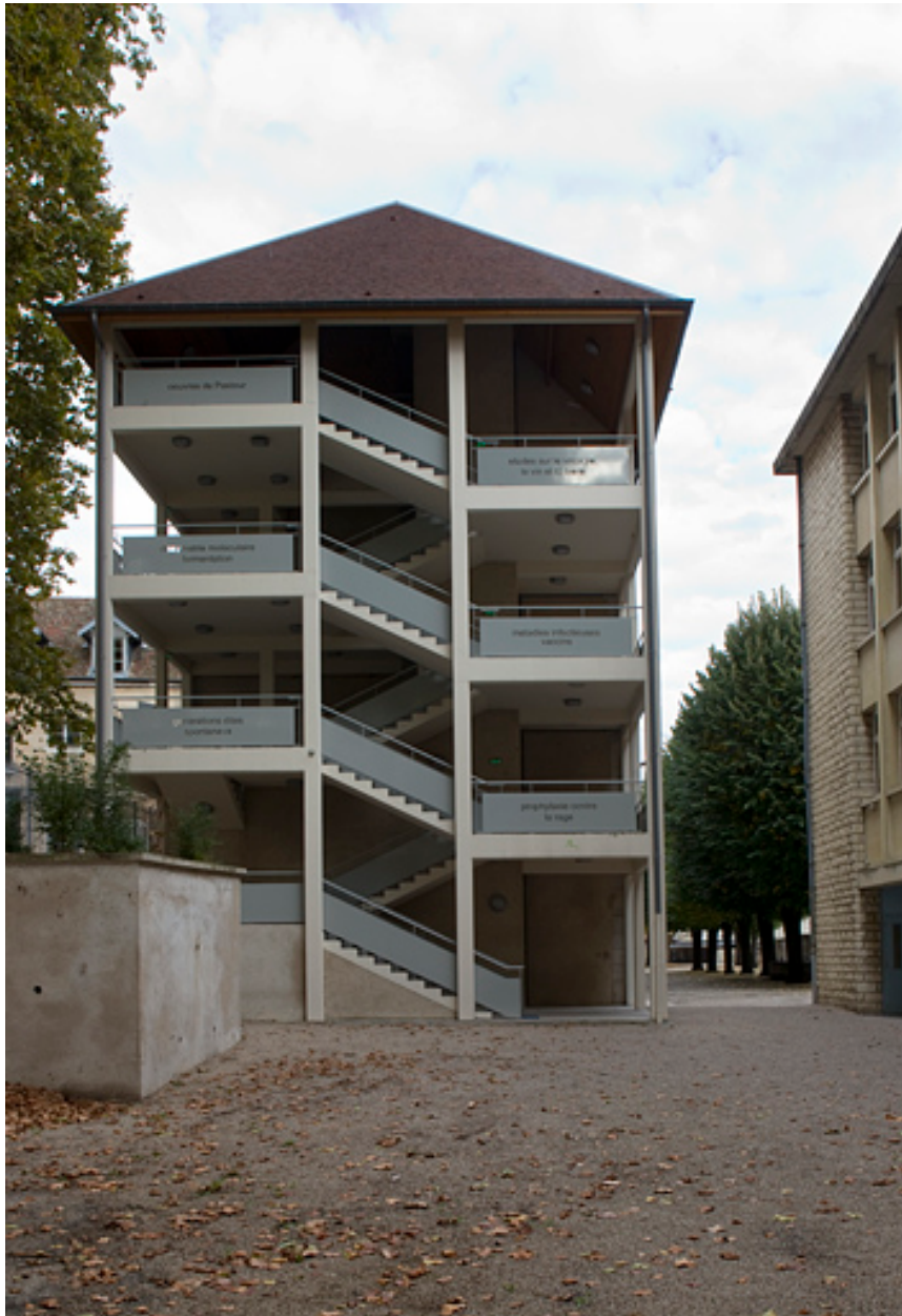
Escalier de distribution extérieur situé à l'extrémité ouest du bâtiment Ducat.
