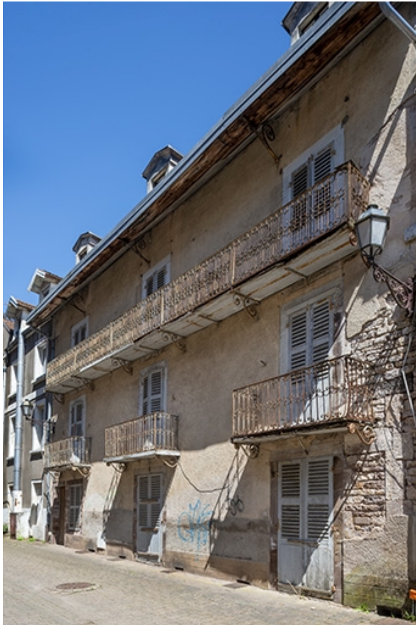
Façade sur l'allée des Romains, vue de trois quarts depuis le sud.
