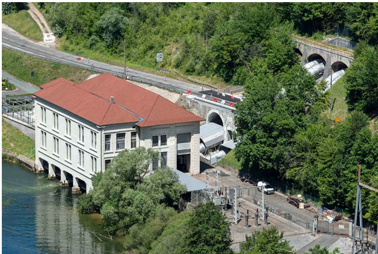
Vue d'ensemble plongeante resserrée, depuis le sud-est.
