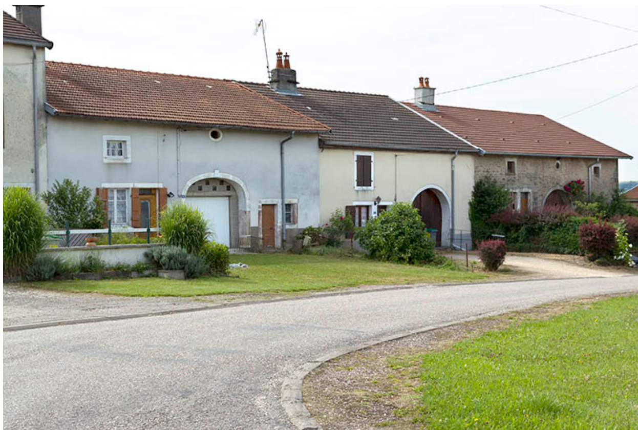
Alignement de fermes, rue de Pont-du-Bois.
