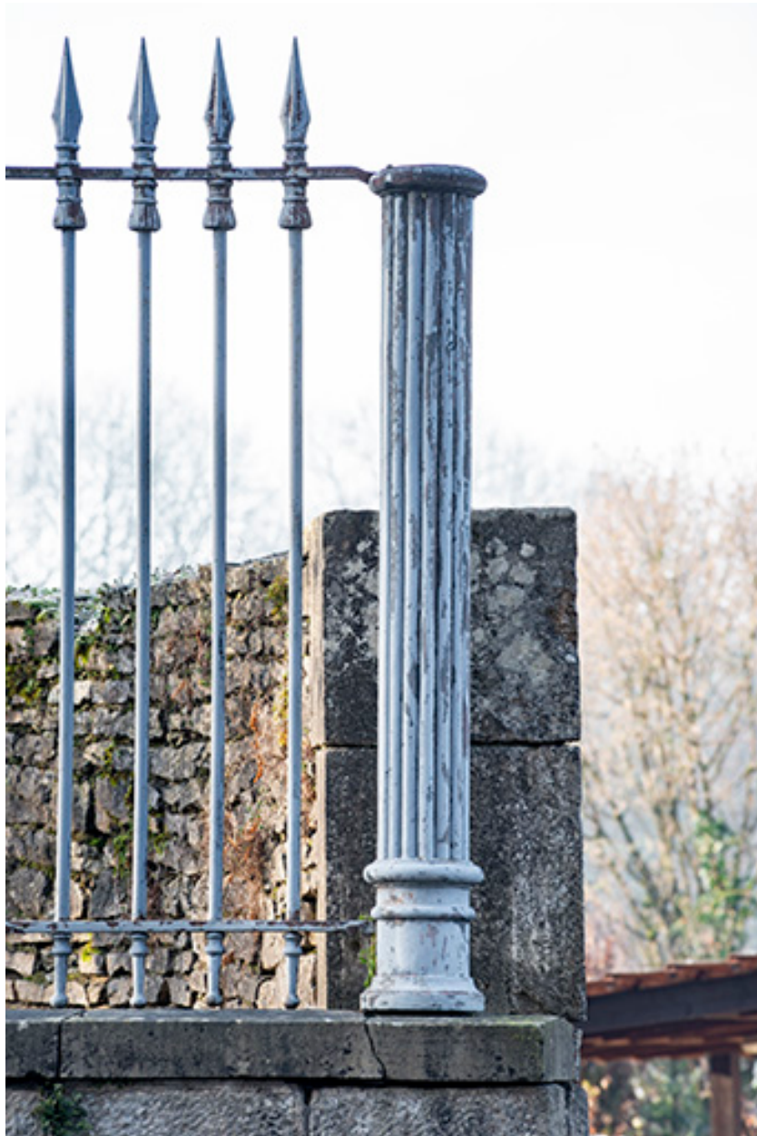
Clôture (grille) sur l'avenue des Pâtis.
