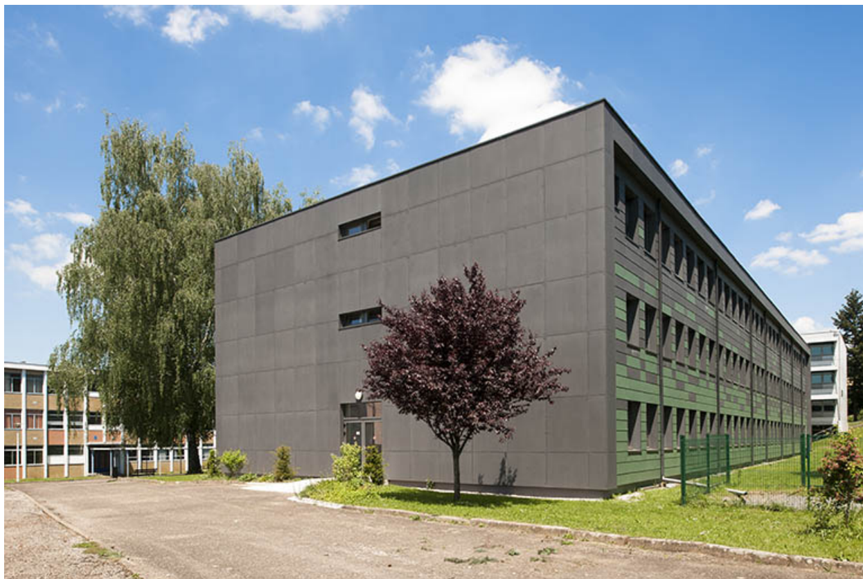
Façade sud et pignon ouest de l'externat.
