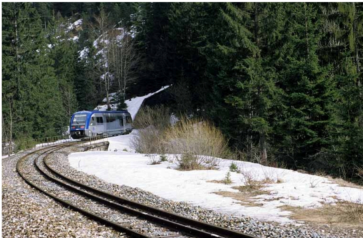
Vue d'ensemble de la voie vers la tête côté Andelot-en-Montagne, avec autorail X 73500.
