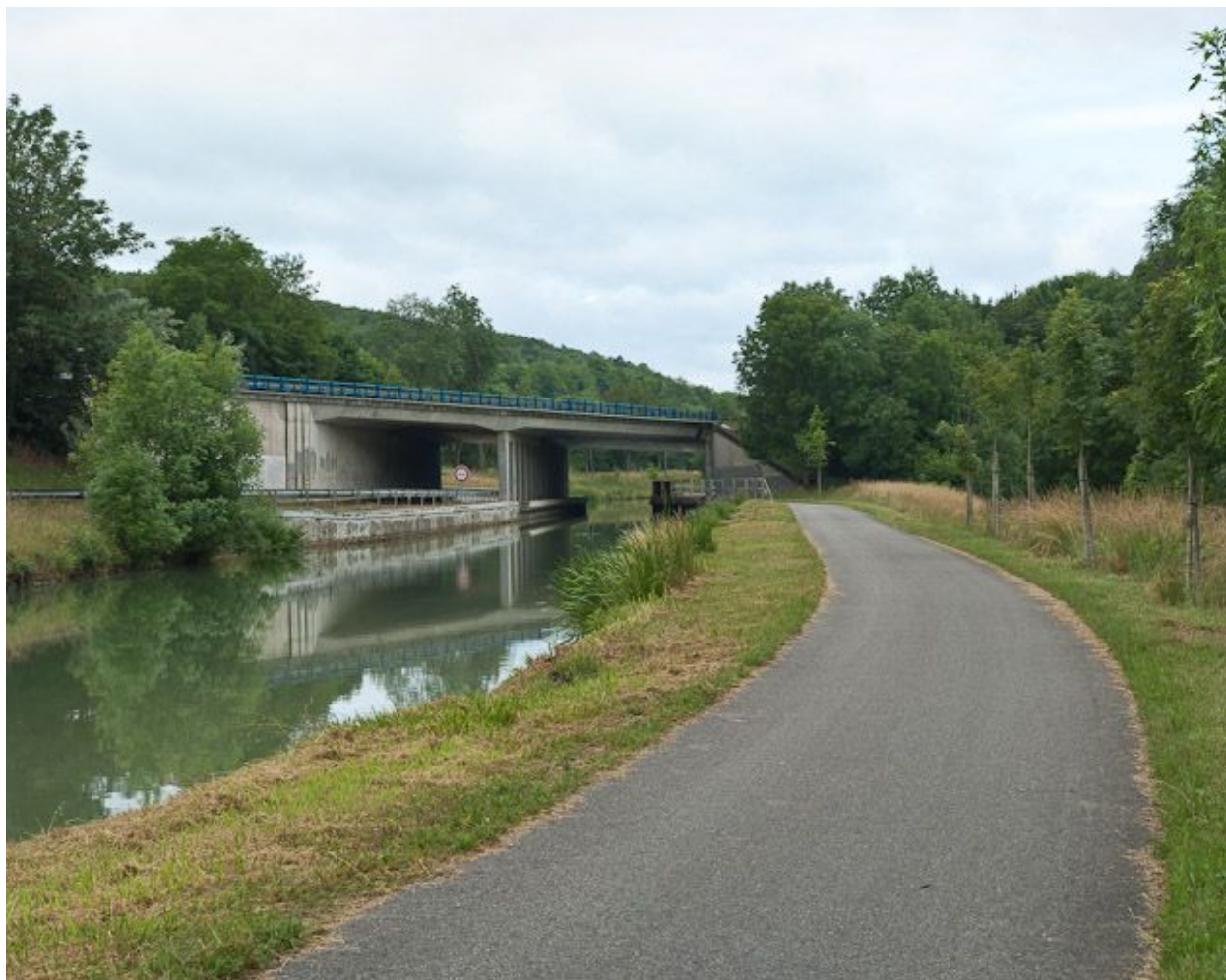
Vue d'ensemble du pont.
