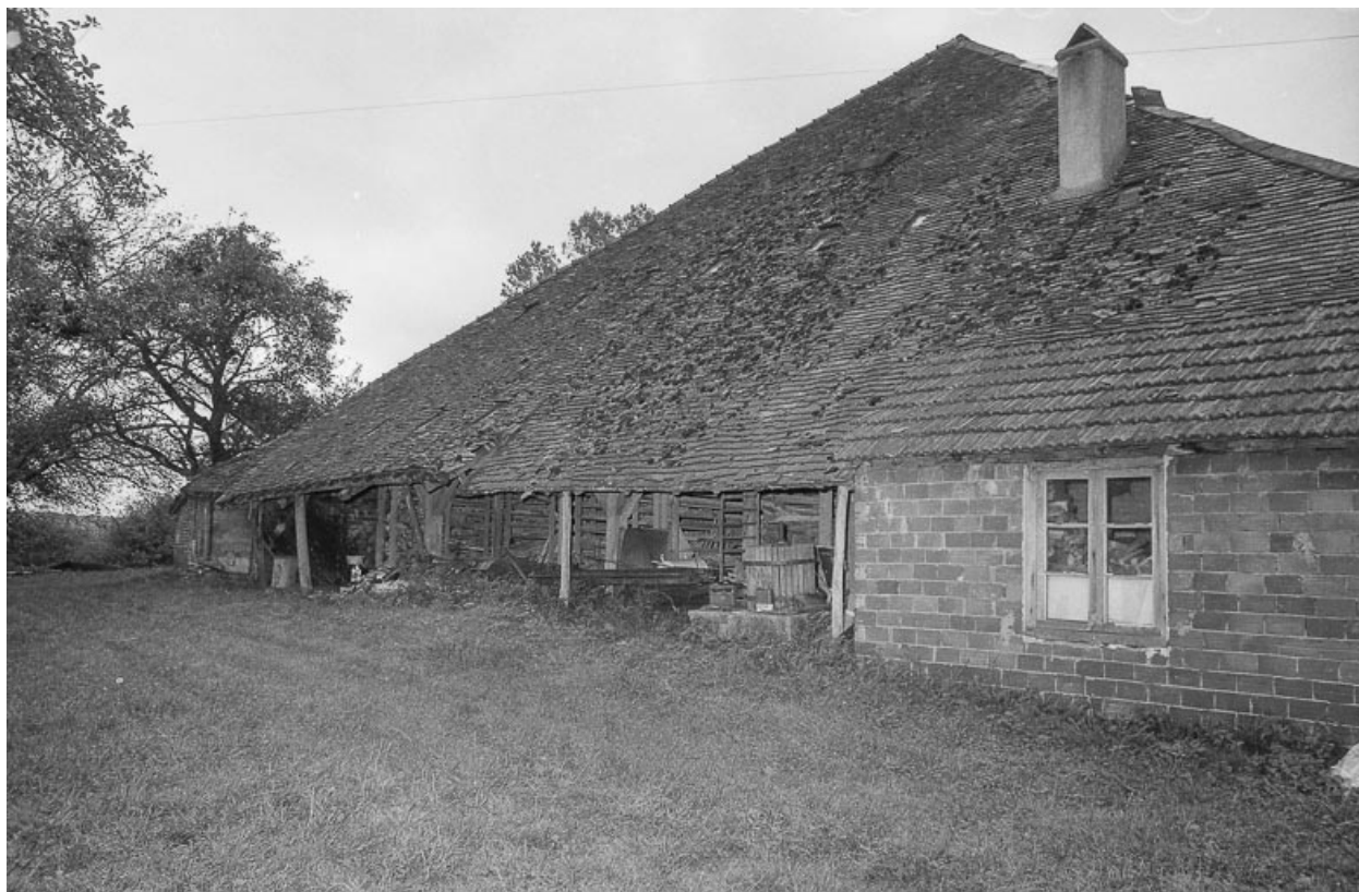
Séchoir : façade antérieure.
