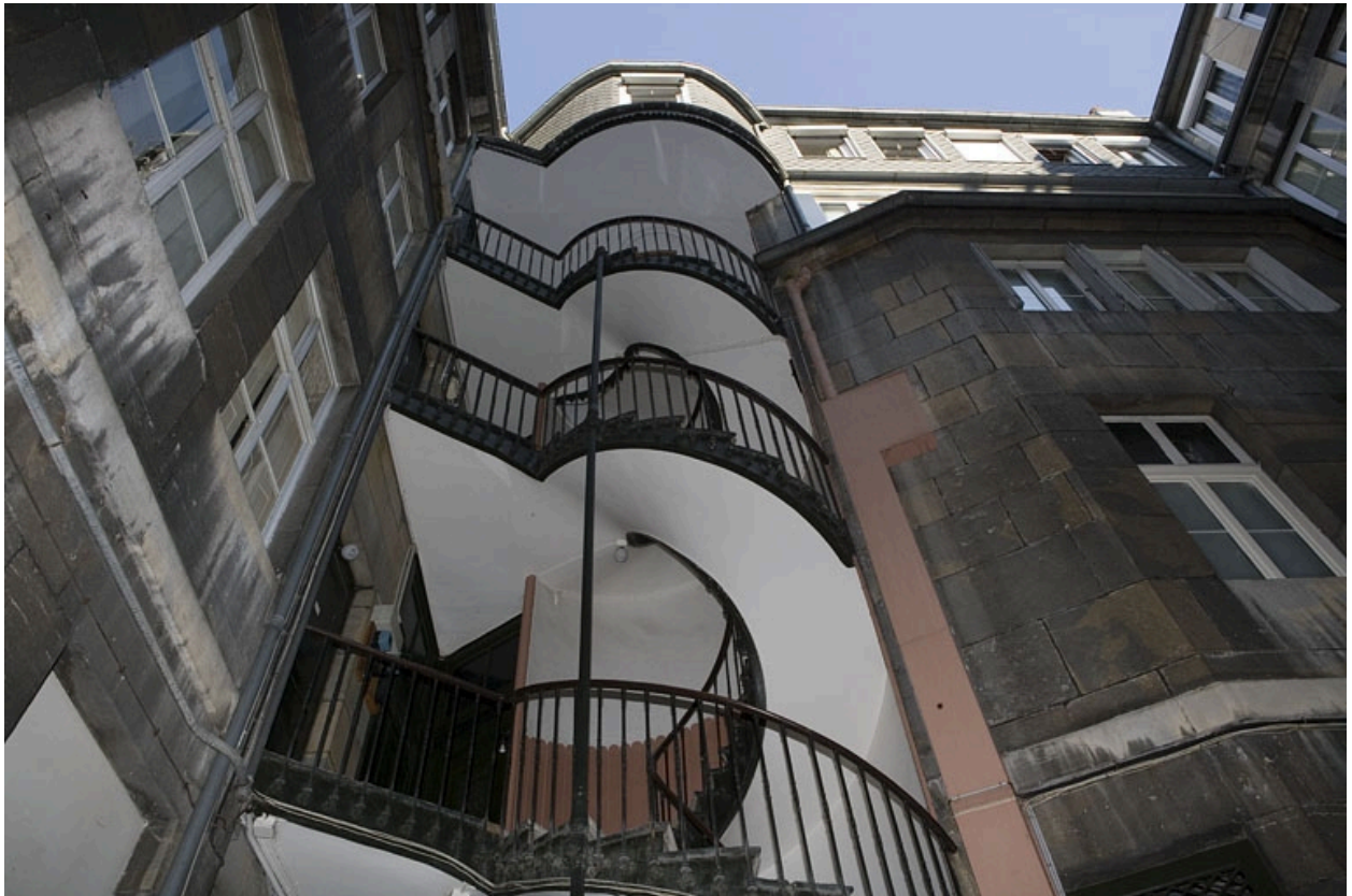
Vue d'ensemble de l'escalier à cage ouverte.
