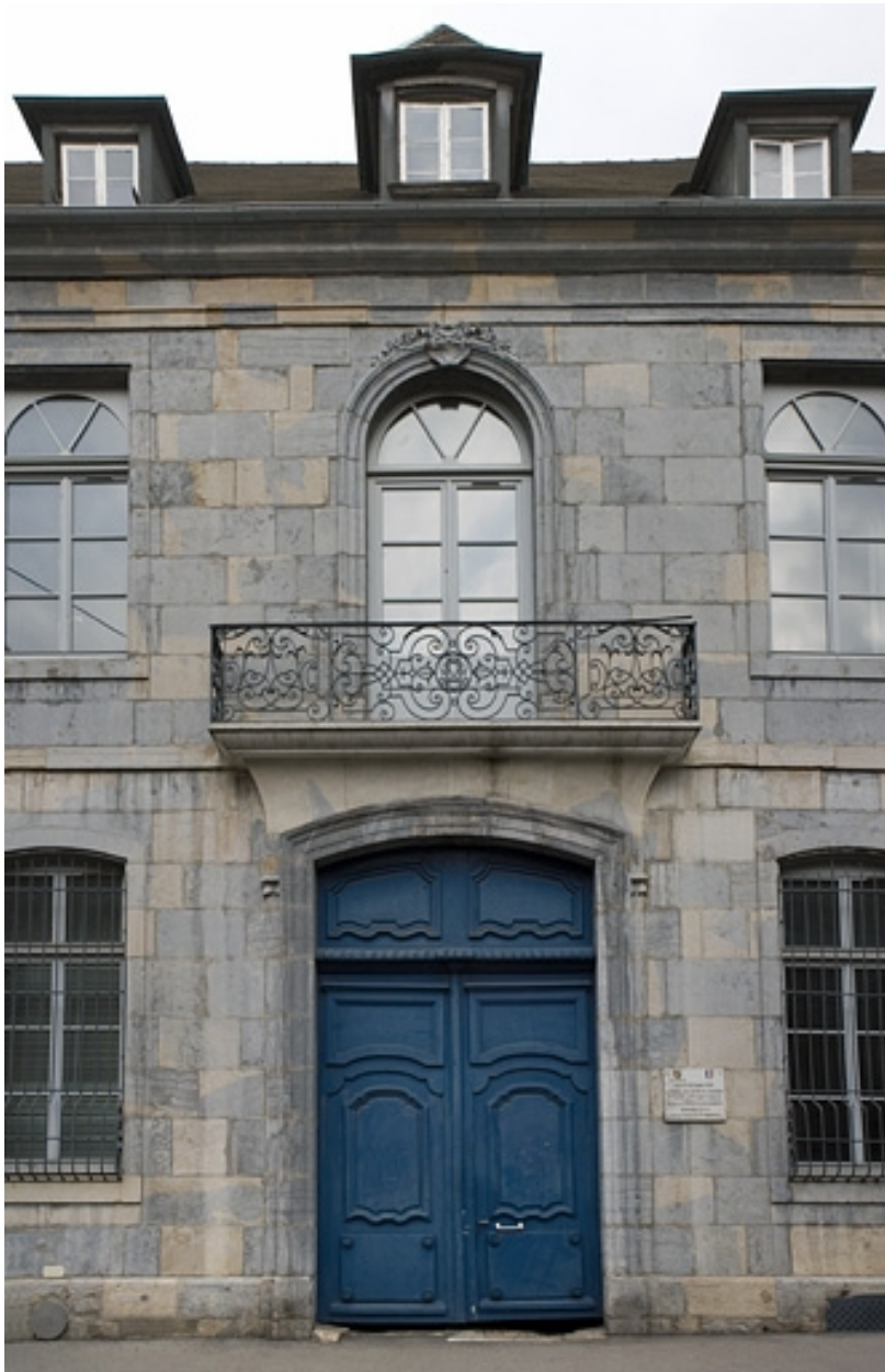
Détail du portail d'entrée et du balcon de la façade sur rue, de face.
